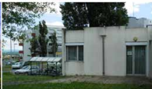
Locaux situés à l'entrée principale de l'hôpital
