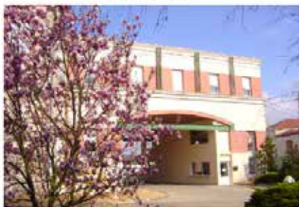
Locaux situés sous le porche de la Maison de Périnatalité
